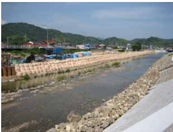
着々と進行する夜市川の付け替え工事
