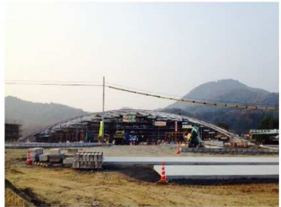
道の駅工事風景
