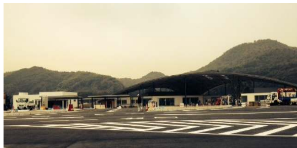
完成間近の道の駅
